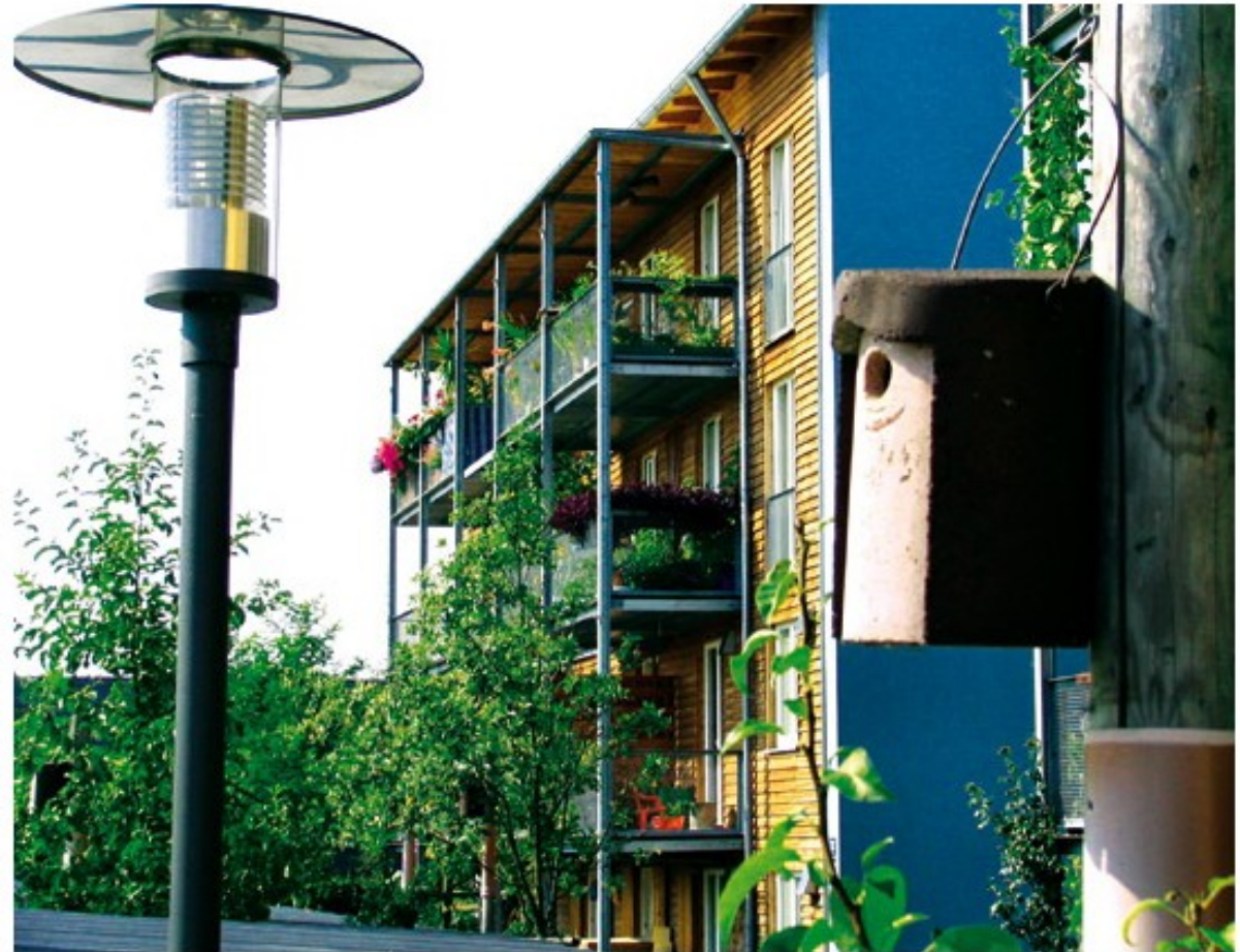
Die Holzfassaden mit den berankten Stahlbalkonen der Wohngebäude an der Caroline-Herschel-Straße bieten insgesamt ein wohnliches und individuelles Erscheinungsbild.
