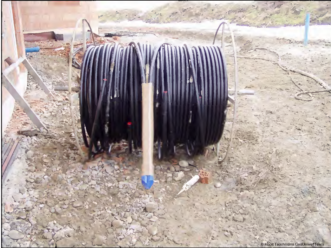
Einbaufertige Erdsonde aus einem PE-Doppel-U-Rohr.
