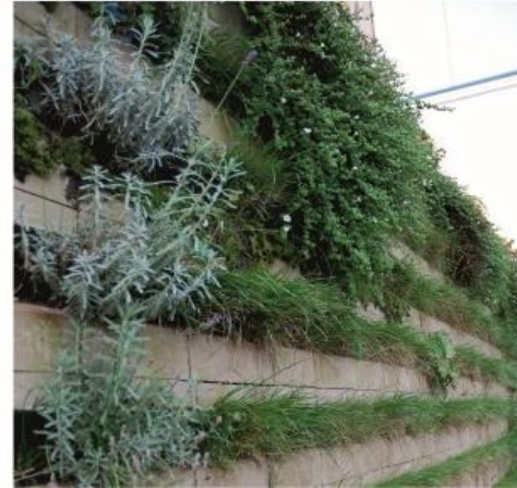
Pflanzsubstrate für Fassadenbegrünung aus 80 % Bauschutt
