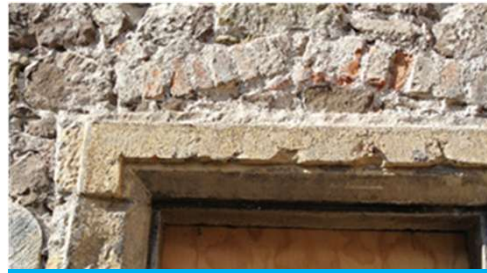
Fenster mit Natursteingewänden
