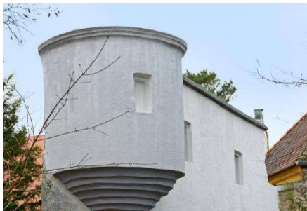
Gesimse, Stuck, Ecken, Kanten, Vorsprünge
