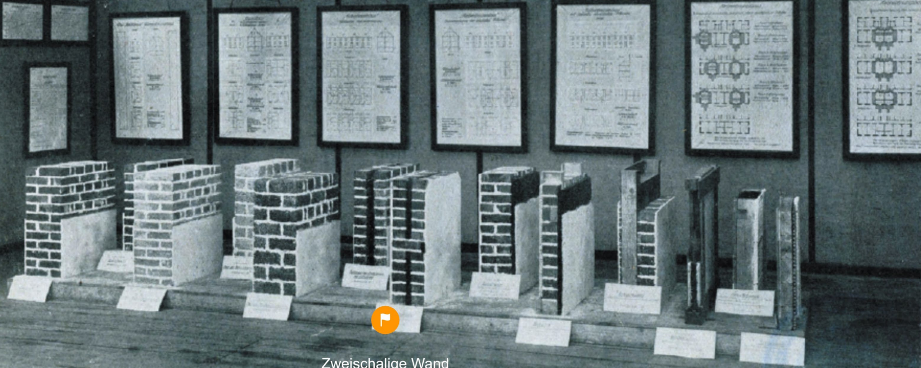
Zweischalige Wand mit Kerndämmung aus Schlacke
