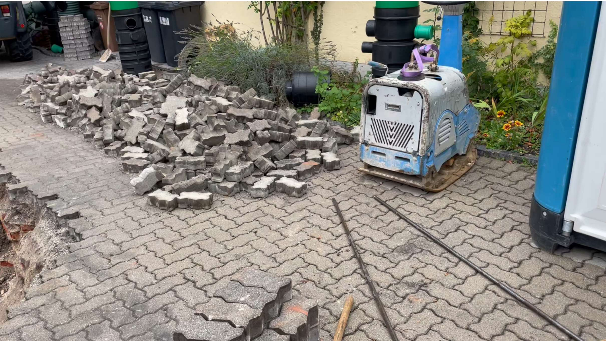
Beispiel 1: Baugrube für Rohr-Rigole
