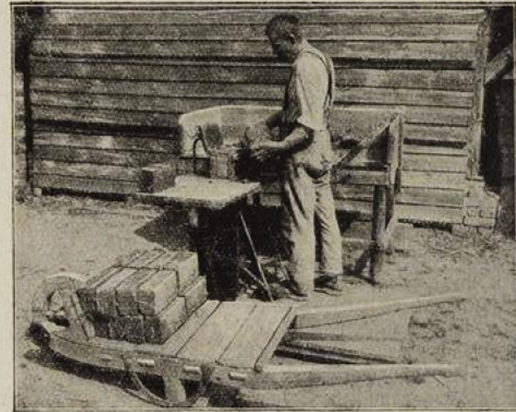
Herstellung von Lehmsteinen für die Innenwände.
