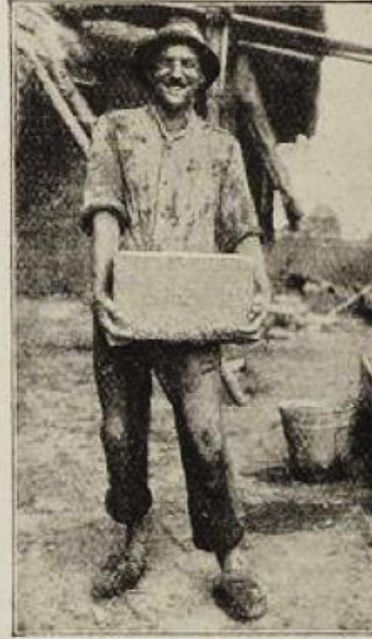
Ein Lehmquader fertig zum Versehen.
