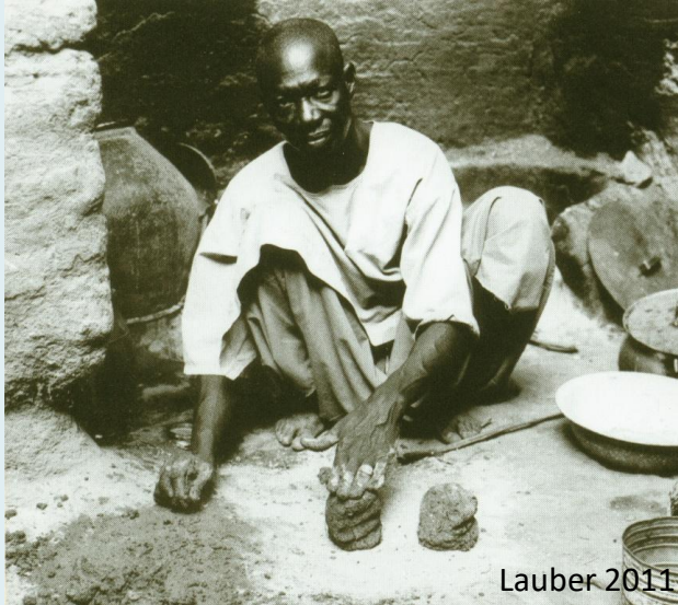
Bere Yono, "maître-mançon" in Djenné (Mali), bei der Herstellung traditioneller "djenné-ferey"
