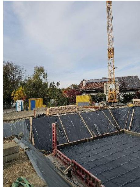
Abdeckung der steilen Böschung
