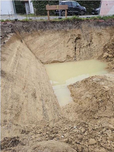
Aushub der Baugrube
