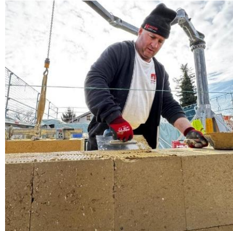
Vermauern im Dünnbettmörtel
