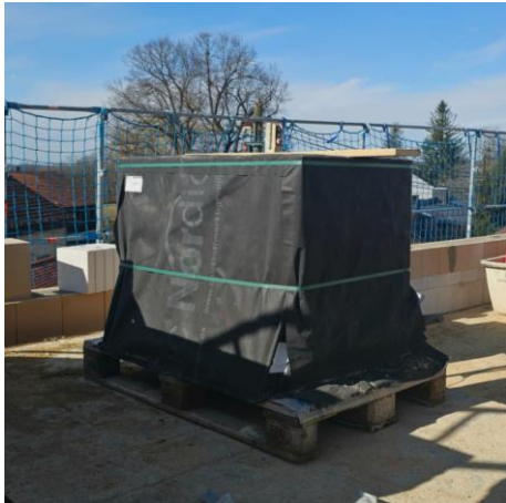
werkseitige Abdeckung der gelieferten Lehmsteine
