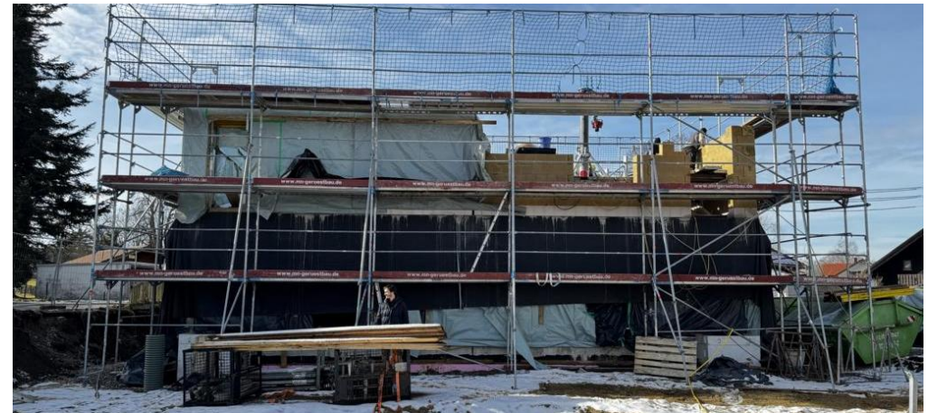
Konstantes und konsequentes Abdecken des fertiggestellten Mauerwerks
