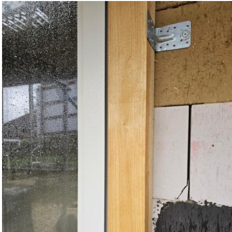
Einbaurahmen aus Holz, um Dichtigkeit zu gewährleisten
