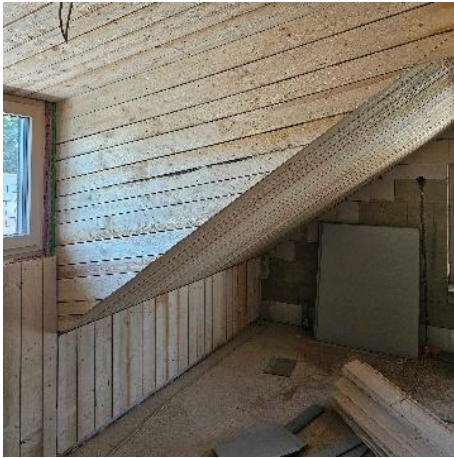
sägerauhe Schalung an Sparren
