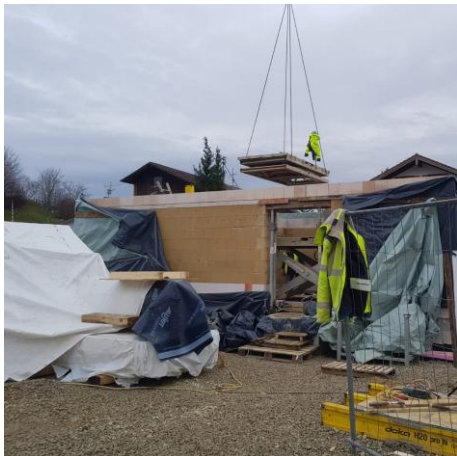
Einbau der Brettstapeldecke
