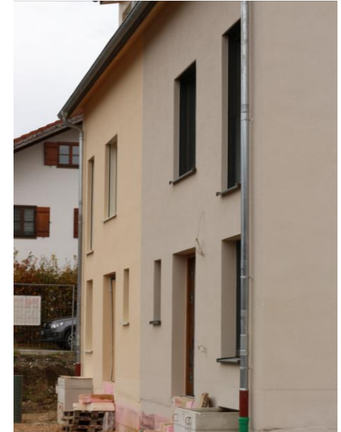
Fassade verputzt und gestrichen
