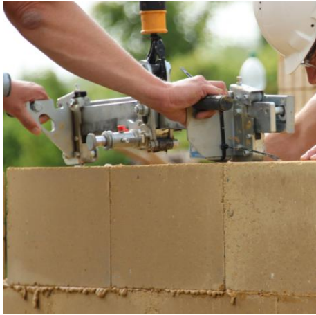
Hebekran mit Zange
