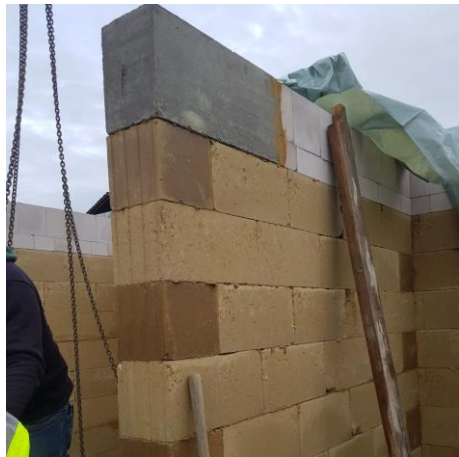
Stb.-Auflager für Stahlträger TH
