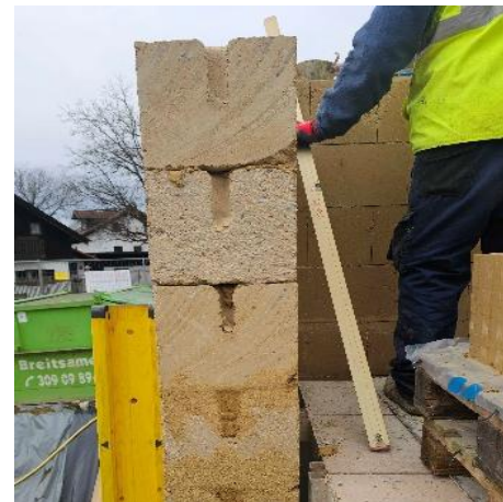
Säge hier: Säge statisch, Stein bewegt sich -> besser umgekehrt, Schneiden der Steine mit Wasser unzulässig => massive Staubentwicklung
