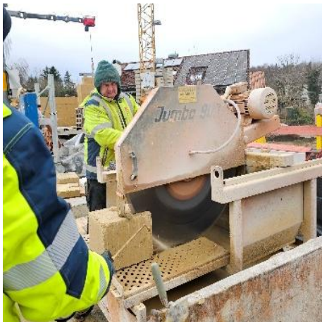
Säge hier: Säge statisch, Stein bewegt sich -> besser umgekehrt, Schneiden der Steine mit Wasser unzulässig => massive Staubentwicklung
