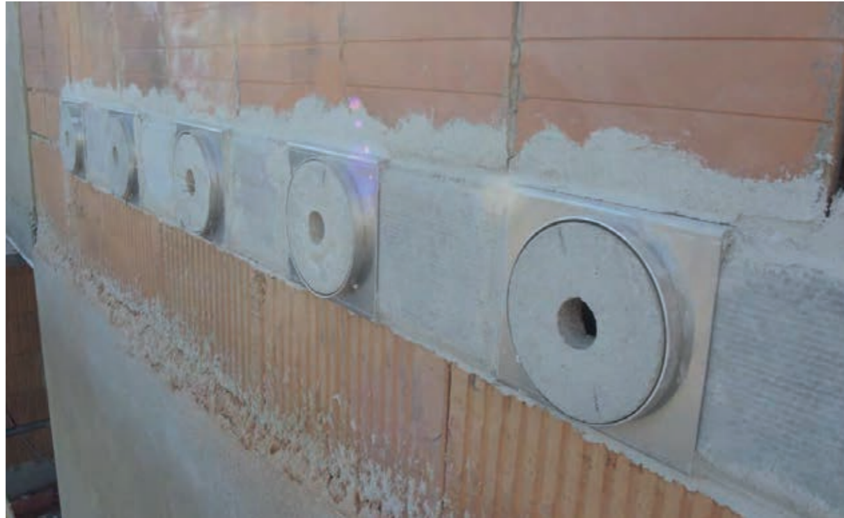
Abb. 4 Rosetten mit Aluminium-Aufsatz vor dem Verputzen (Bild: Sylvia Weber, LBV)
