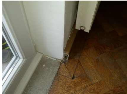
Zweirohrheizung in der Sockelleiste und Bodenverlegung
