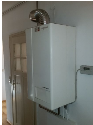
Kombitherme Heizung und Warmwasser
