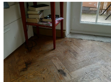
Zweirohrheizung in der Sockelleiste und Bodenverlegung
