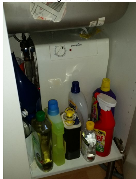
Untertischboiler 2 KW
