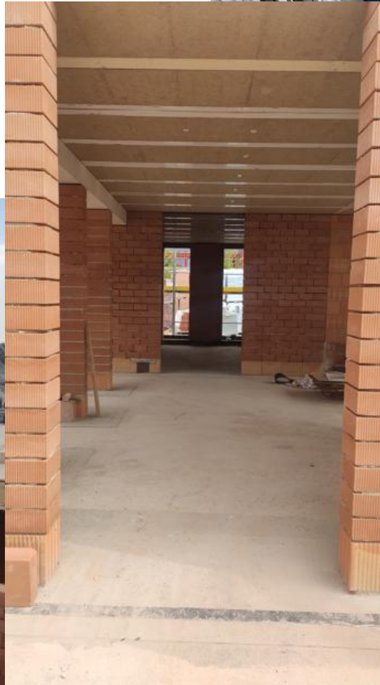
Holz-Lehm-Massivdecke mit Fließlehm im Werk hergestellt
