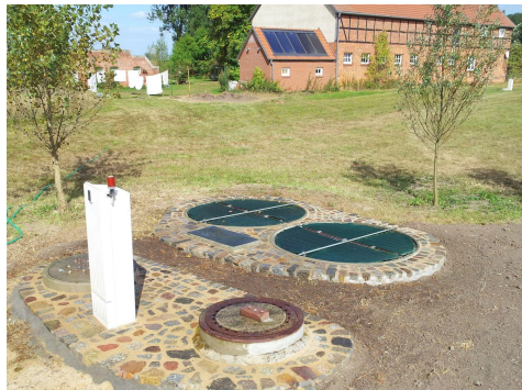
Pflanzenkläranlage reinigt Abwasser
