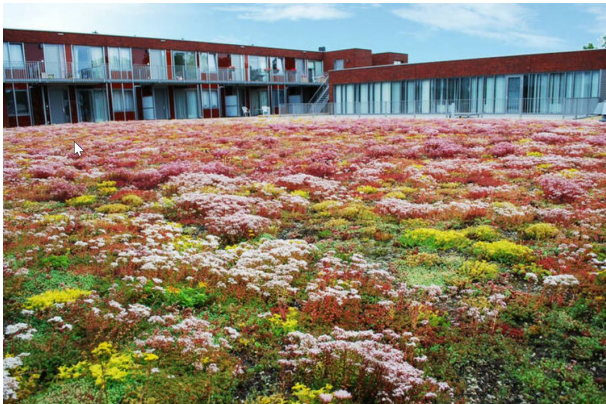
extensive Dachbegrünung als natürliche Klimaanlage
