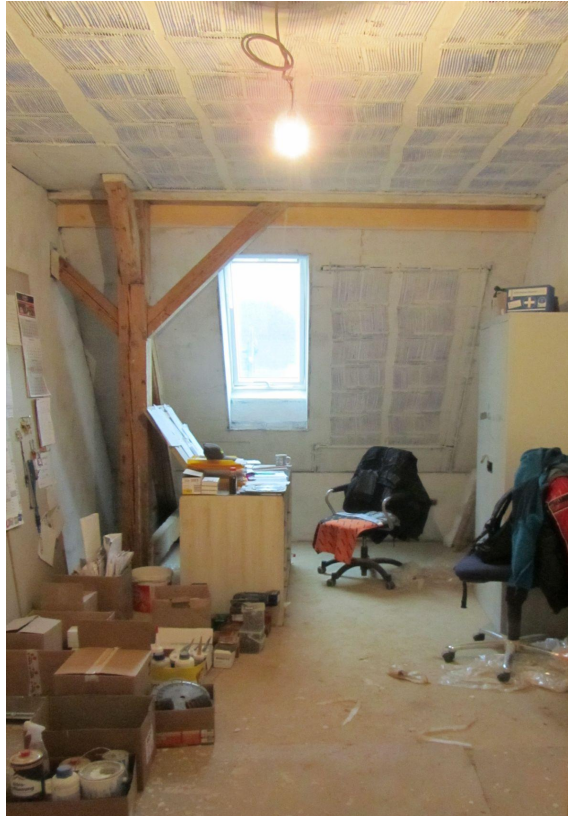
Verputzen der Kapillarrohrmatten
