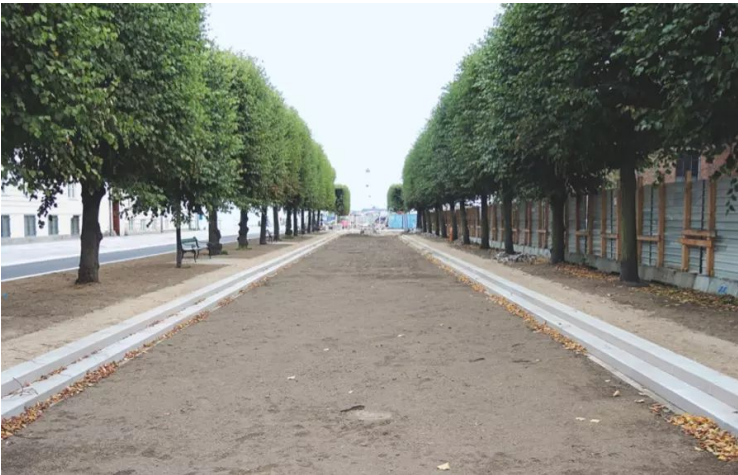
Tieferlegung des historischen Sankt Annæ-Plads für den temporären Rückhalt von Regenabflüssen
