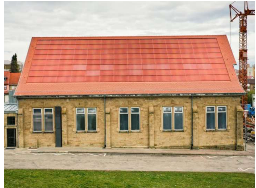
Historische, aber nicht denkmalgeschützte Sporthalle in Eppingen mit farbigen MorphoColor-Solarmodulen als Dacheindeckung ©Fraunhofer ISE
