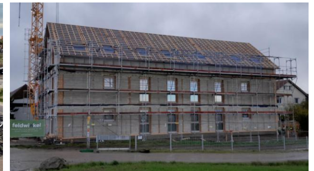
vorgefertigte Bauelemente Integration in den modernen Holzbau Zimmerei Grünspecht eG
