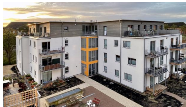
vor Ort Stroheinbau Meilenstein MFH in GK4
