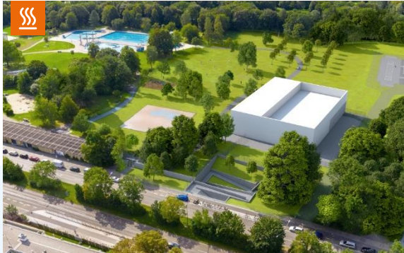
Geothermieranlage Michaeliabad In Umsetzung
