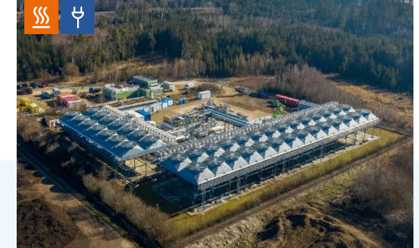
Geothermie-Heizkraftwerk Kirchstockach In Betrieb mit Strom seit 2013, Wärme seit 2021
