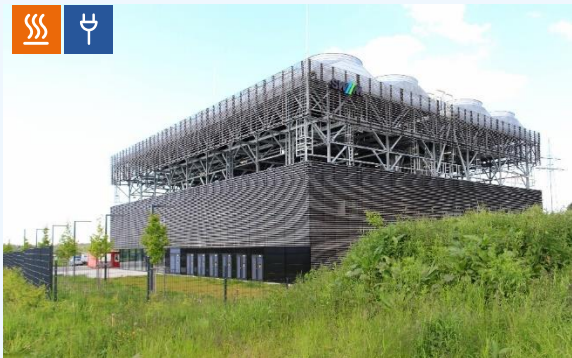
Geothermie-Heizkraftwerk Sauerlach In Betrieb seit 2013
