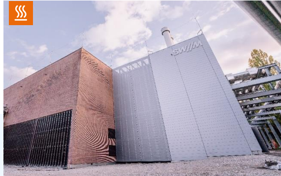
Geothermieranlage Energiestandort Süd In Testbetrieb seit 2021
