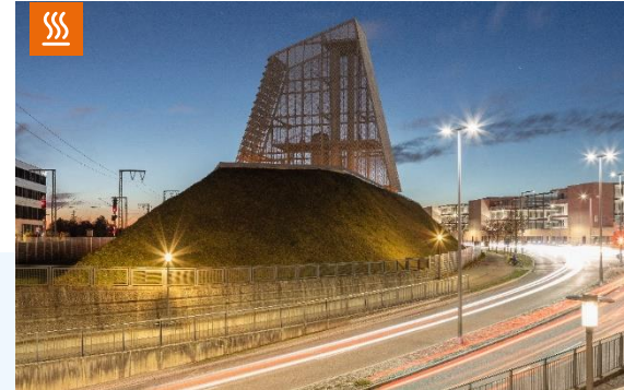
Geothermieranlage Freiham In Betrieb seit 2016
