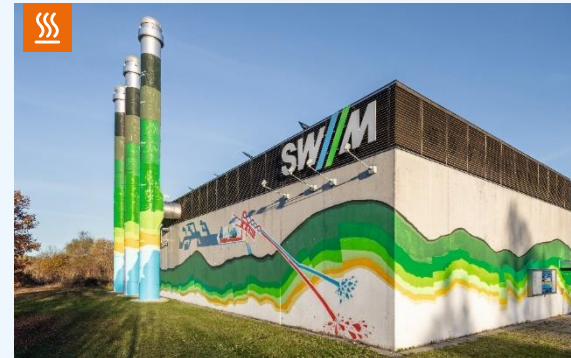
Geothermieranlage Riem In Betrieb seit 2004
