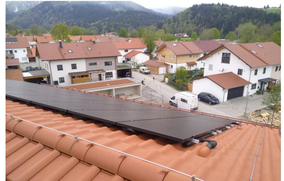
Neubau Mehrfamilienhaus mit 23 Wohneinheiten im Bereich kommunaler Wohnungsbau
