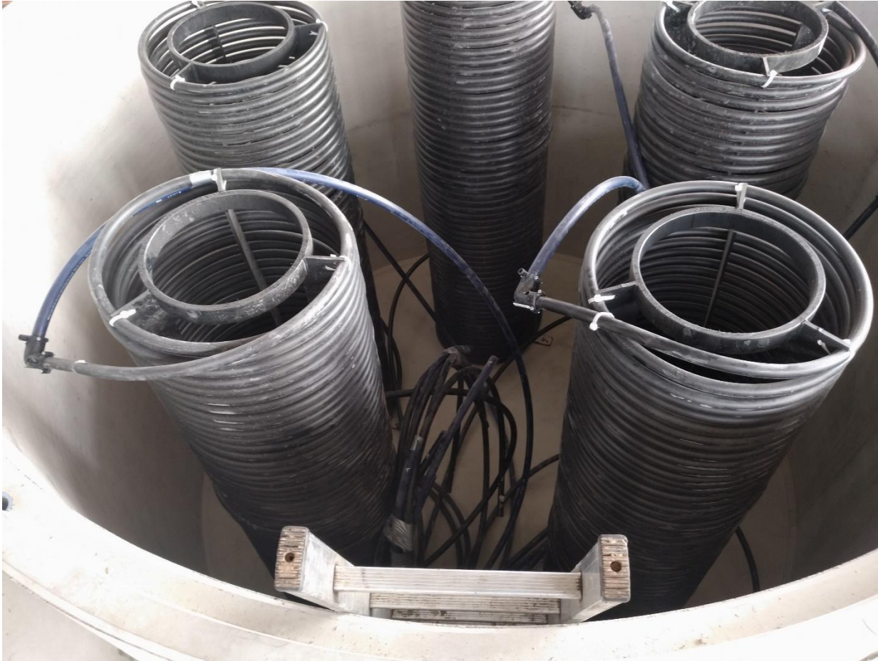
Kreise auf PE-Verteiler geschweißt
