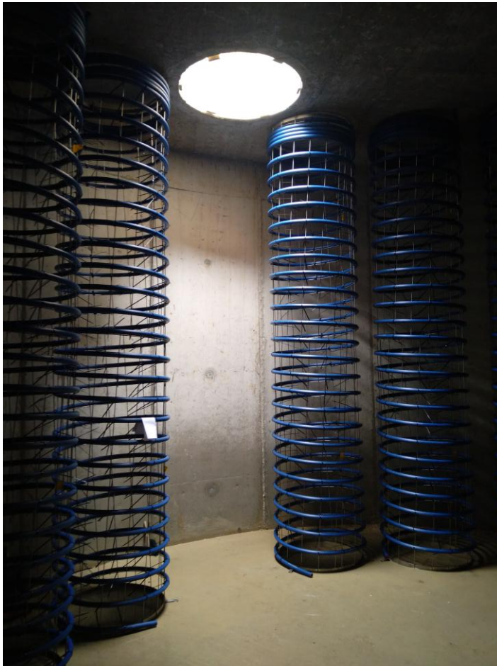
Einbringen der Wärmetauscher
