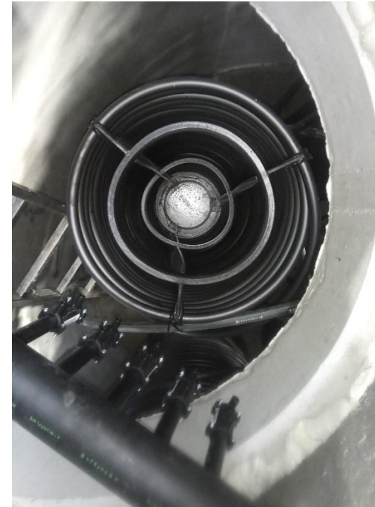
Kreise auf PE-Verteiler geschweißt
