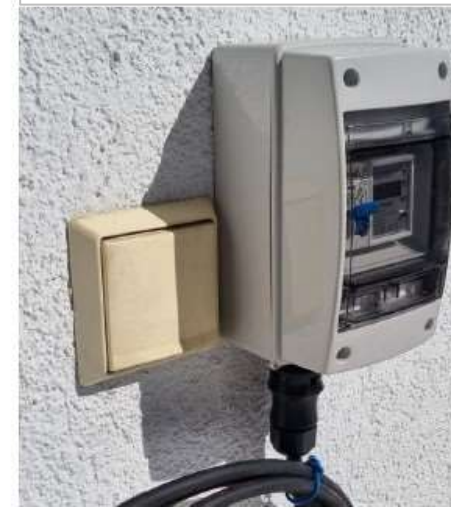
Anschlussbeispiel mit Wieland Stecker und Smart Meter
