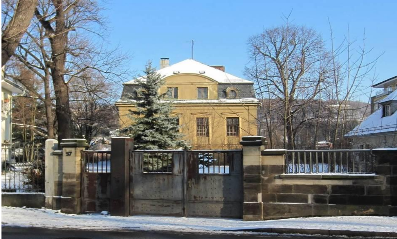
Bsp.: „Wiedergutmachung“ Dresden, vorher
