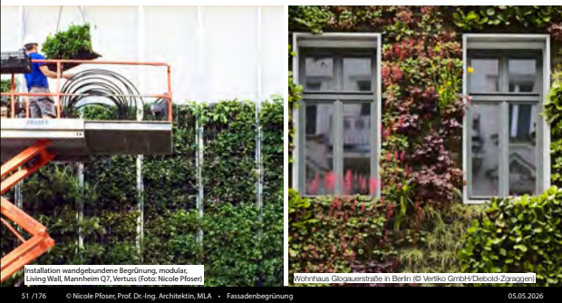
Installation wandgebundene Begrünung, modular, Living Wall, Mannheim (© Vertiko (Foto: Nicole Pflöser))
