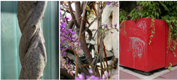
Dickenwachstum: Auslenkung der Stahlseile, Anhebung von Pflanzbehältern. Abb.: Nicole Pfoser
