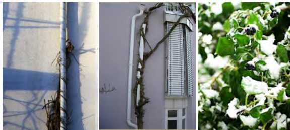
Falsche Pflanzenwahl, Starkschlinger an Regen-Fallrohr: Hinterwuchs, beginnende Zerstörung.
