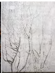
Efeu-Haftwurzeln nach Bewuchsentfernung, www.flickr.com, Ex-Efeu, © ds
