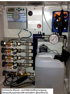
Technische Wasser- und Nährstoffversorgung Überprüfungsintervalle einhalten! (Brandhorst)
