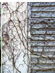
Einwachsen der Begrünung in offene Bauteilfugen. Ungenügende Pflege/falsche Pflanzenentscheidung.
