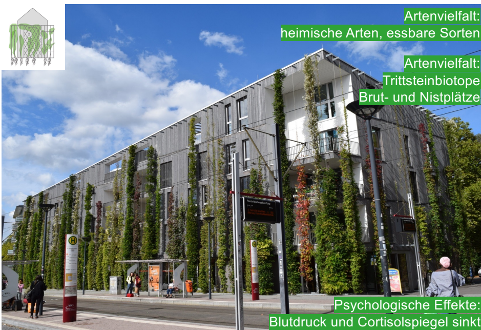
Wohn- und Bürogebäude, Freiburg im Breisgau
