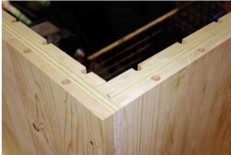
Wandsystem Kerto in Leno vereint Vorteile des Kerto-Furnierschichtholz mit Eigenschaften der Massivholz-Bauteile LenoTec © Finnforest Merk
