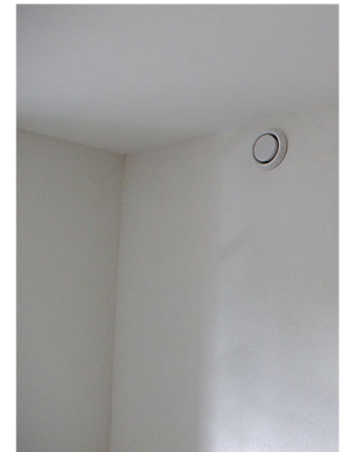
Quelle: Fa. inVENTer, Löberschütz: iV-Twin+ Einzelraumlüftung
