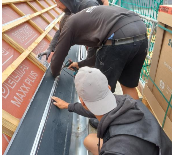
Trauf- oder Starterprofil montieren
