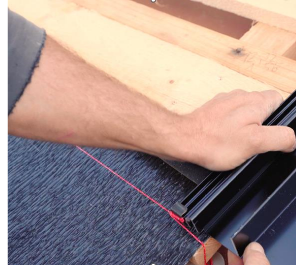
Randprofile und Seitenblech rechts einlegen
