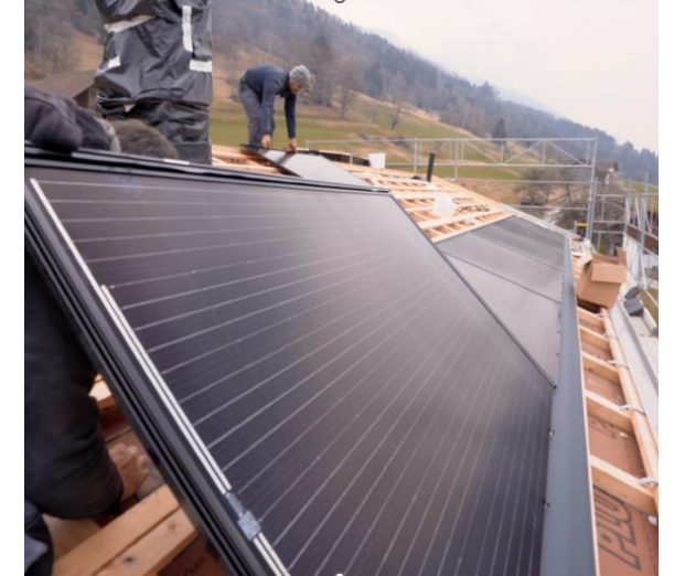
Module einlegen und elektrisch verbinden
