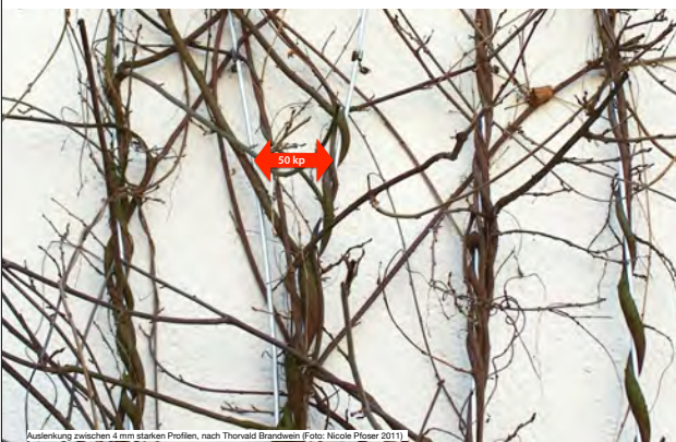
Auslenkung zwischen 4 mm starken Profilen, nach Thorwald Brandwein (Foto: Nicole Pflöser 2011).
