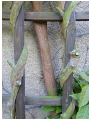
Ungeneignete Pflanzenwahl/ungeeignete Materialwahl Starkschlinger (Wisteria sinensis) an filigranem Rankgitter.
