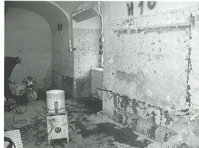
Bild 8. Injektionsmitteleinbringung mittels Druckverfahren
