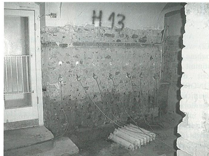
Bild 10. Trocknung oberhalb der Abdichtungsebene
