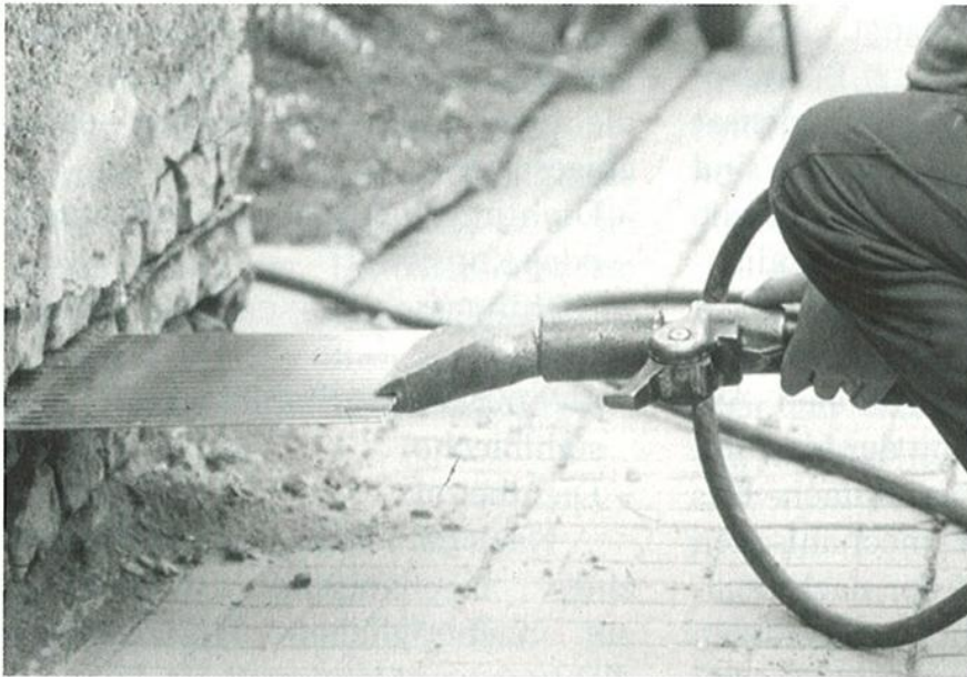
Bild 2. Materialien und Einbringung – Chromstahlblechverfahren
