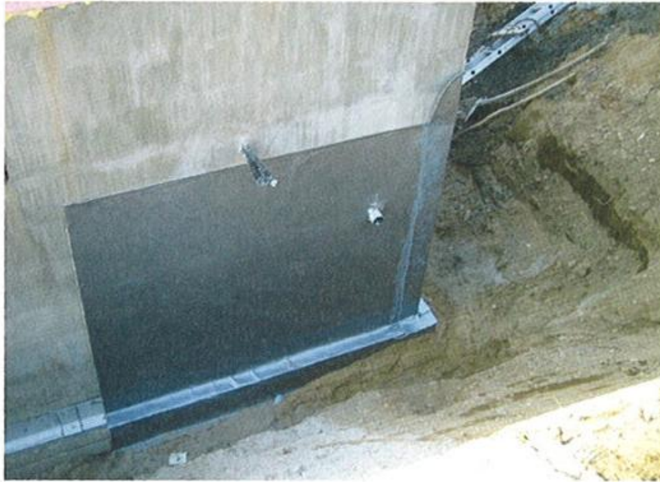
Bild 2. Ecklösung einer Wandabdichtung mit SilverSeal
