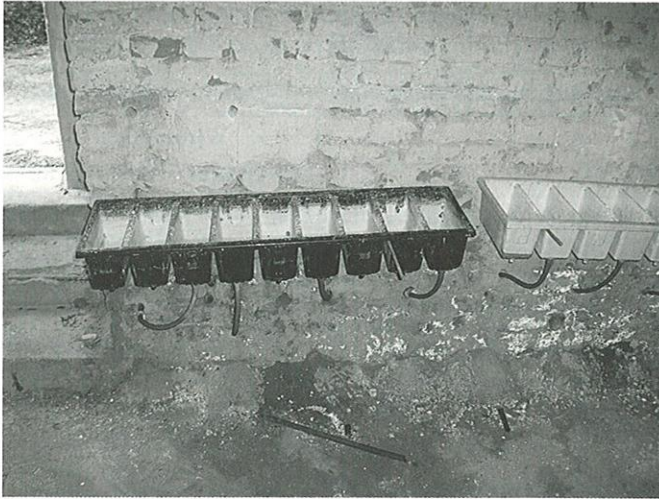
Bild 7. Injektionsmitteleinbringung mittels Hohldochtverfahren
