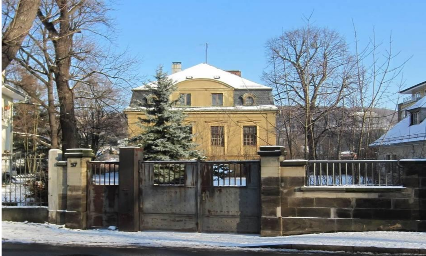
Bsp.: „Wiedergutmachung“ Dresden, vorher
