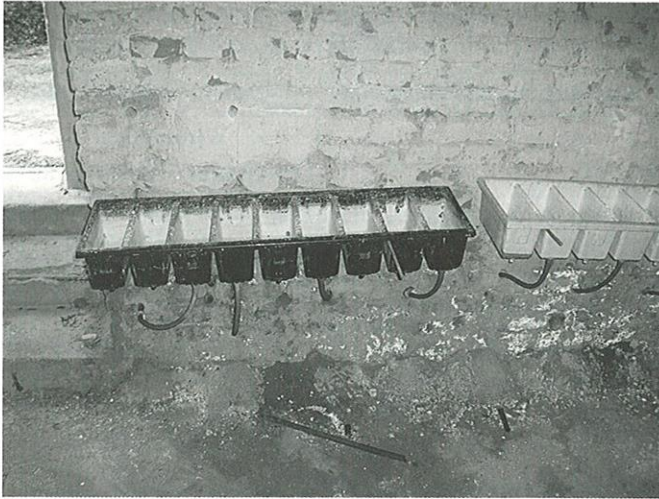
Bild 7. Injektionsmitteleinbringung mittels Hohldochtverfahren
