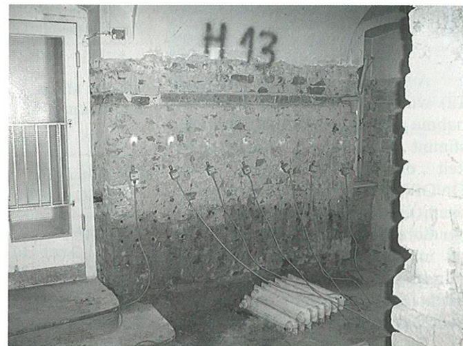
Bild 10. Trocknung oberhalb der Abdichtungsebene
