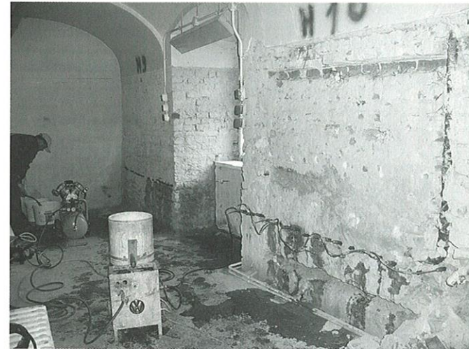
Bild 8. Injektionsmitteleinbringung mittels Druckverfahren
