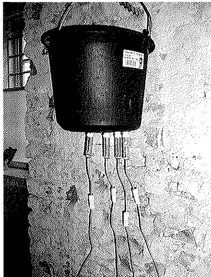
Bild 5. Bewässerung der Injektionsebene mittels spezieller Bewässerungseinrichtung
