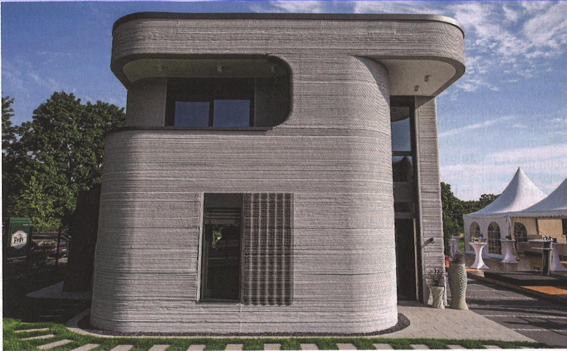
3-D-Drucker-Einfamilienhaus in Beckum: In 100 Stunden aus der Düse
