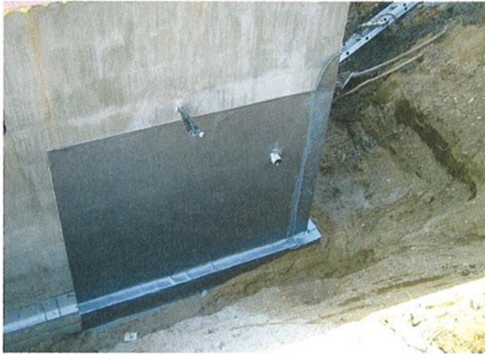
Bild 2. Ecklösung einer Wandabdichtung mit SilverSeal
