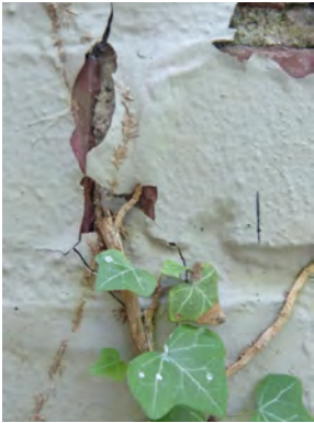
Efehaftwurzeln an kunststoffvergüteter Dispersionsfarbe/Unterwanderung. Ugeeigneter Haftgrund für Selbstklimmer
