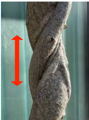
Ungünstige Pflanzenwahl/ungeeignete Materialwahl, Starkclimber (Wisteria sinensis) an Sekkonstruktion, Verkürzung der Seillänge, Herausreißen der Verankerung
