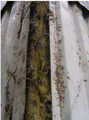
Einwachsen von Fleu in offene Bauteilfugen und Dämmung. Falsche Pflanzen- bzw. Materialentscheidung. © Andreas Schreier, Deutsche Foamglas GmbH
