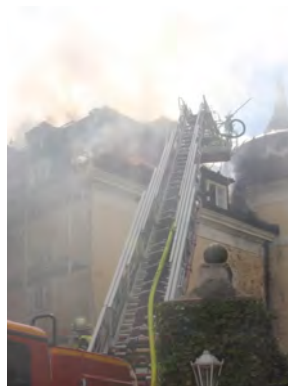
Hausbrand durch Abflammen von Haftwurzeln (Hedera Helix) www.ssddeutsche.de - 16.08.2012 „Feuer verwüstet denkmalgeschützte Villa“
