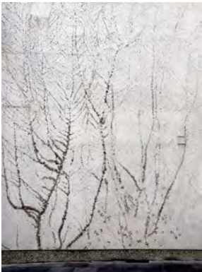
Efeu-Haftwurzeln nach Bewuchsentfernung. www.flickr.com , Efe-Efeu, © de
