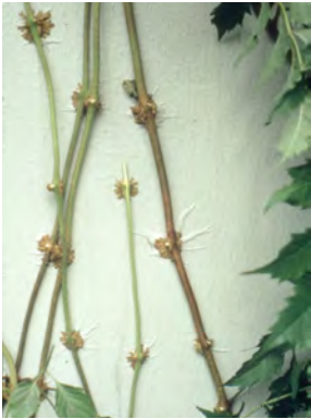
Bildung atypischer Ernährungswurzeln bei Campsis radicans unter fließbildender, schadensverursachender Kunststoffbeschichtung (Biotenschutz), © Prof. C. Althaus
