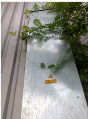
Einwachsen der Begrünung in offene Bauteilfugen. Ungenügende Pflege/falsche Pflanzenentscheidung. Abb.: Vertiko GmbH
