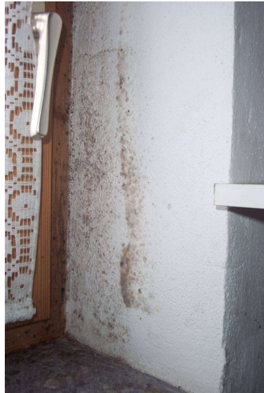
Schimmel durch Wärmebrücken
