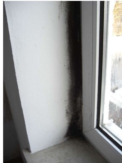
Schimmel durch Wärmebrücken
