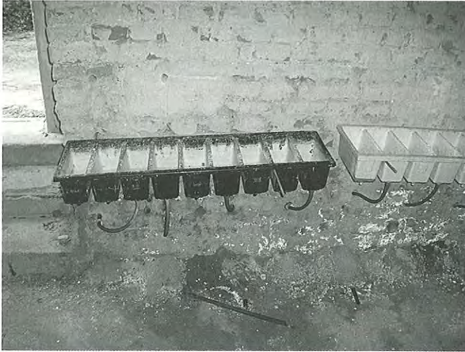
Bild 7. Injektionsmitteleinbringung mittels Hohldochtverfahren
