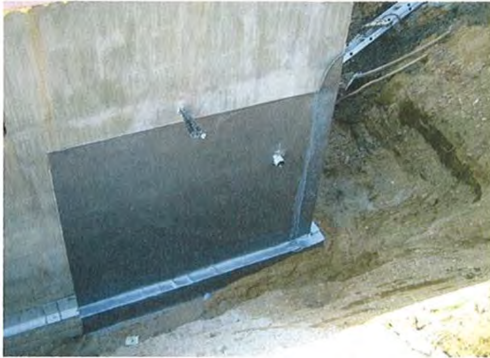
Bild 2. Ecklösung einer Wandabdichtung mit SilverSeal
