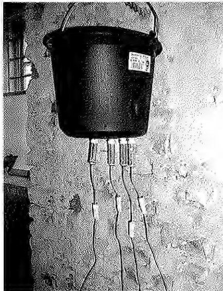
Bild 5. Bewässerung der Injektionsebene mittels spezieller Bewässerungseinrichtung
