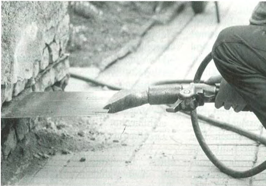
Bild 2. Materialien und Einbringung – Chromstahlblechverfahren
