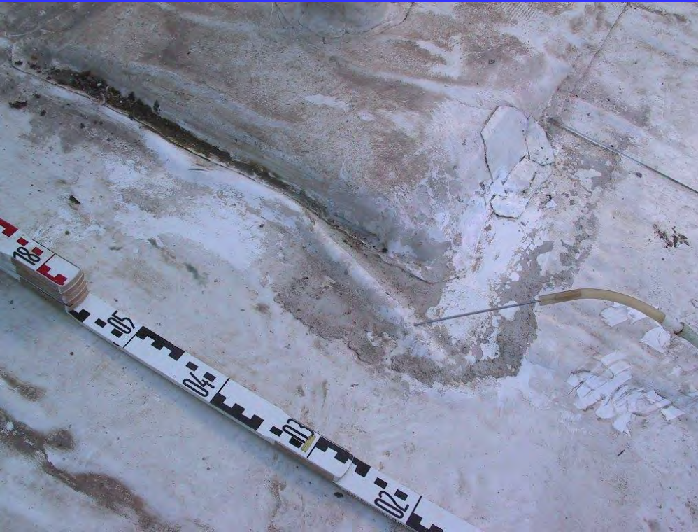
Gaseinführung unter Foliendach
