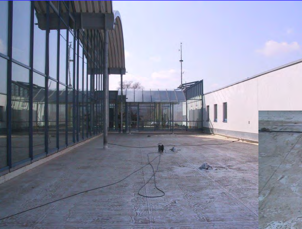
Tracer-Gas Methode auf trockenem Foliendach
