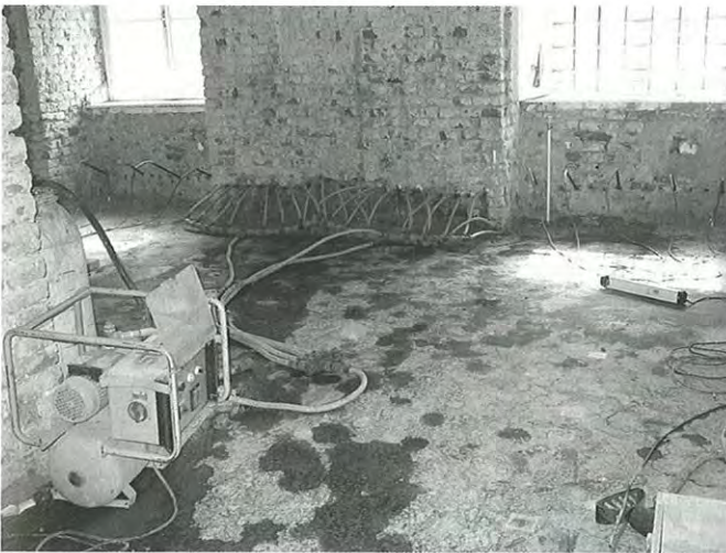
Bild 9. Injektionsmitteleinbringung mittels Impulsprühverfahren
