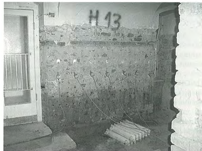
Bild 10. Trocknung oberhalb der Abdichtungsebene
