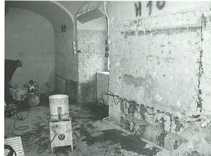
Bild 8. Injektionsmitteleinbringung mittels Druckverfahren
