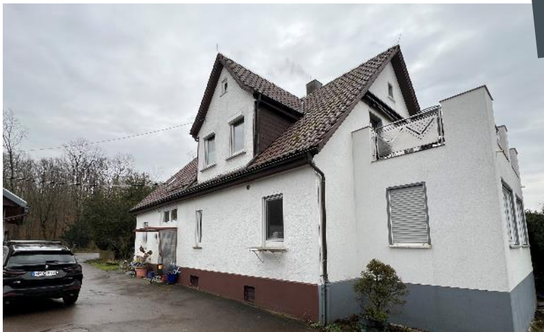
Bildquelle: Holzbau Göser
