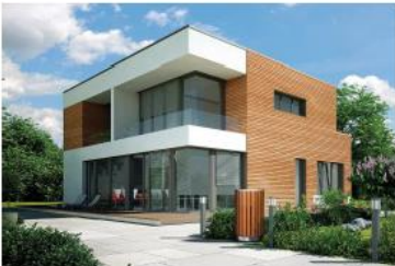
WP im Neubau
