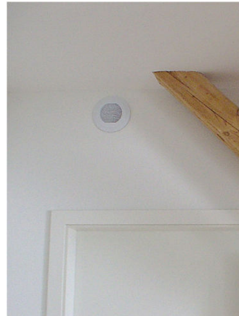
Quelle: Fa. inVENTer, Löberschütz: iV-Twin+ Einzelraumlüftung
