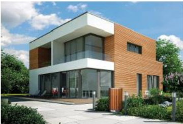
WP im Neubau
