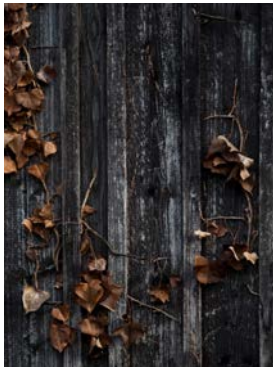
Pilzfall an Holzoberfläche unter beseitigtem Hedera helle Bewuchs www.fotozoo.com , Holzwand mit Efeu, © mivale
