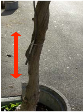
Starkachsliger (Wisteria sinensis) an Seilkonstruktion, Verkürzung der Seillänge, Auslösung der Überlastsicherung
