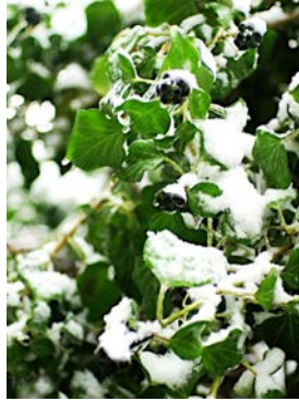
Eislast und Schneelast an Fassadenbegrünung (Fledera Helix)
