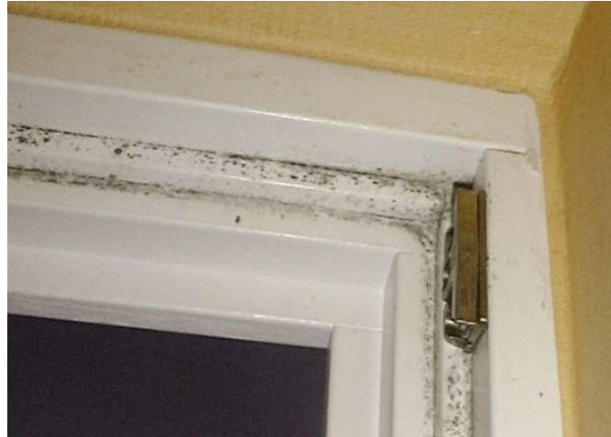
Erhöhter Tauwasserausfall
