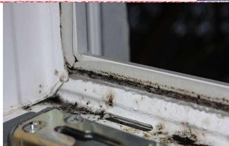
Erhöhter Tauwasserausfall
