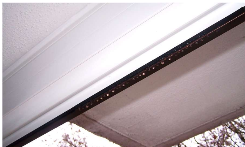
Tauwasser am Druckausgleich
