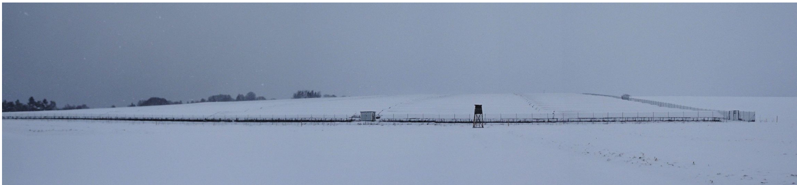
10 MW Freiflächen-Solaranlage (PV) bei Irlahüll am 26.01.2021
