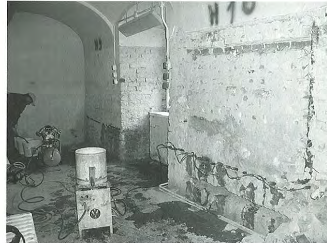
Bild 8. Injektionsmitteleinbringung mittels Druckverfahren
