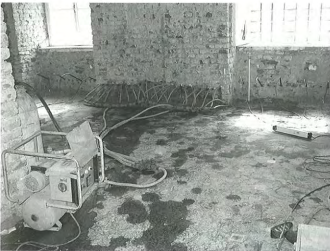
Bild 9. Injektionsmitteleinbringung mittels Impulsprühverfahren
