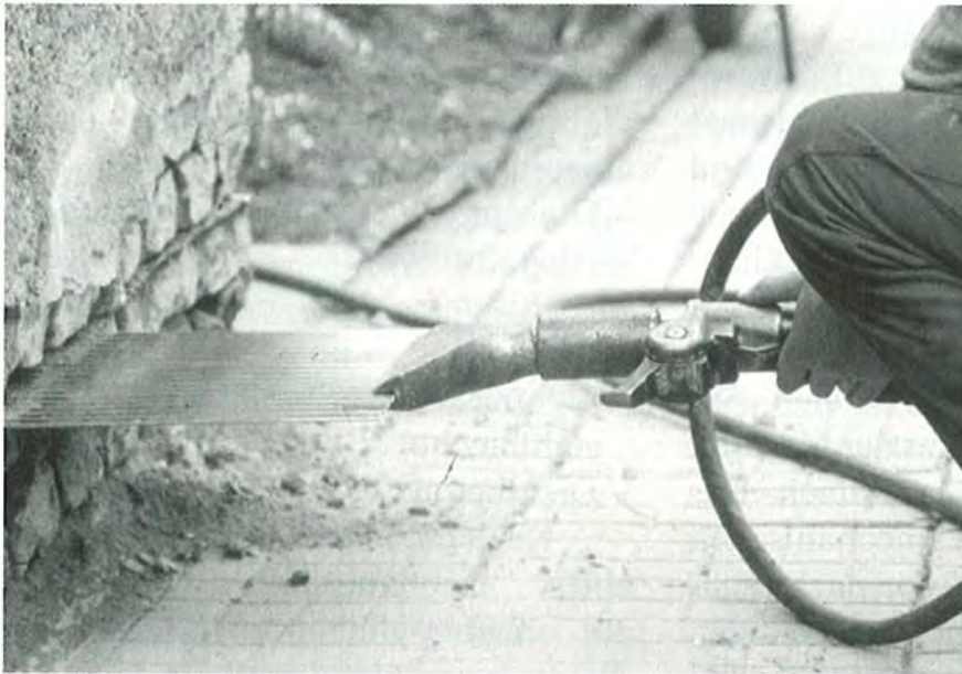
Bild 2. Materialien und Einbringung – Chromstahlblechverfahren
