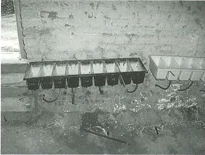
Bild 7. Injektionsmitteleinbringung mittels Hohldochtverfahren
