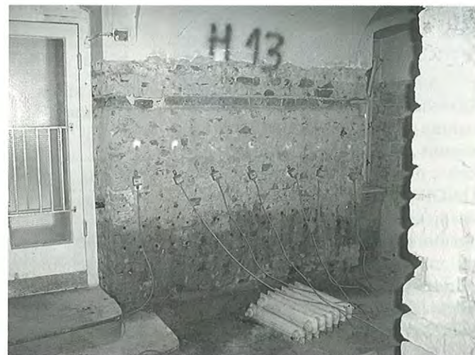
Bild 10. Trocknung oberhalb der Abdichtungsebene
