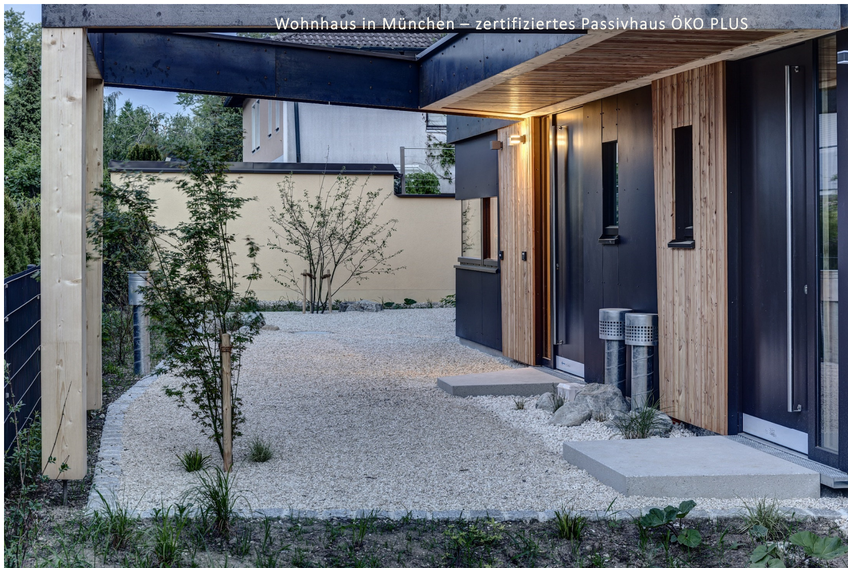
Eingangssituation mit Lüftungsauslässen
