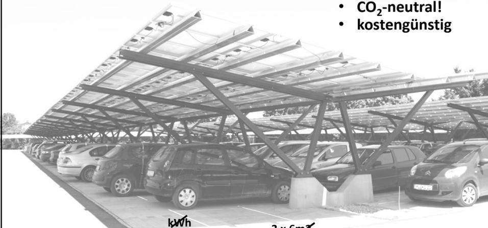
$$\frac{\text{Reichweite}}{\text{Jahr}} = \frac{900 \frac{\text{kWh}}{\text{km}} \times \text{Jahr} \times 3 \times 6 \text{ m}^2}{\frac{20 \text{ kWh}}{100 \text{ km}} \times 8 \frac{\text{m}^2}{\text{kWh}}} = 10.125 \frac{\text{km}}{\text{Jahr}}$$
