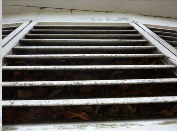
*Durch Laub zugesezter Außenluftdurchlass*
