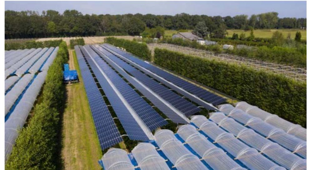
Hagelschutznetze im Obstbau werden durch eine Agri-PV-Anlage überflüssig (© BayWa r.e.)
