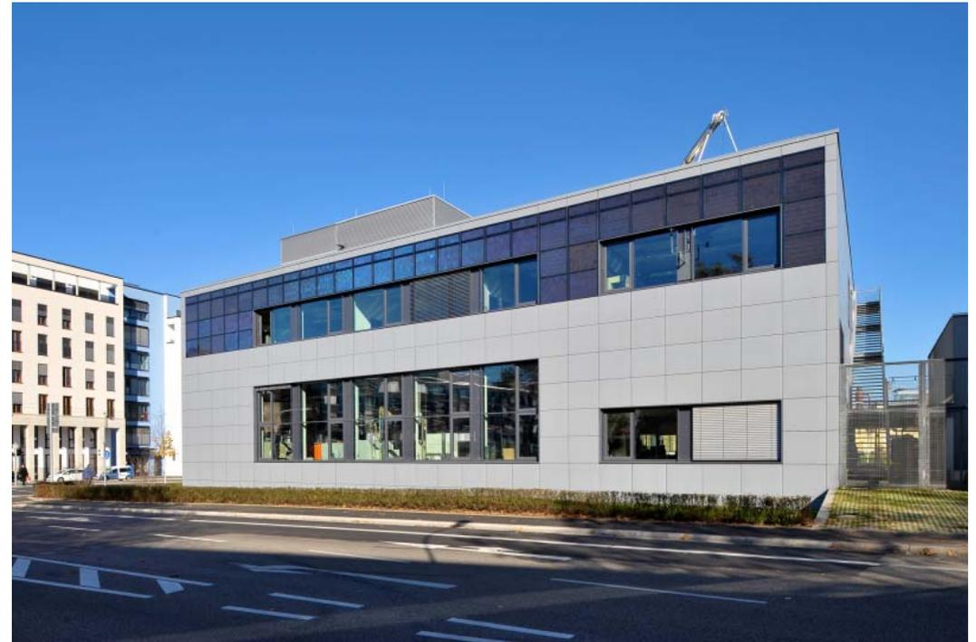
Gebäudeintegrierte PV (BIPV, ISE-Labor)
