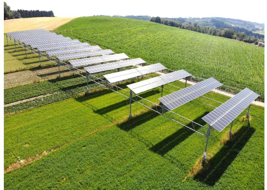
APV Versuchsanlage mit 194 kWp bifaziale PV-Module
